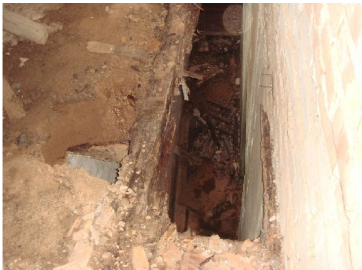
F-4 Pārsegums. Sija gar asi "3" satrupējusi. Melno griestu dēļu iebrukusi telpā nr.3
